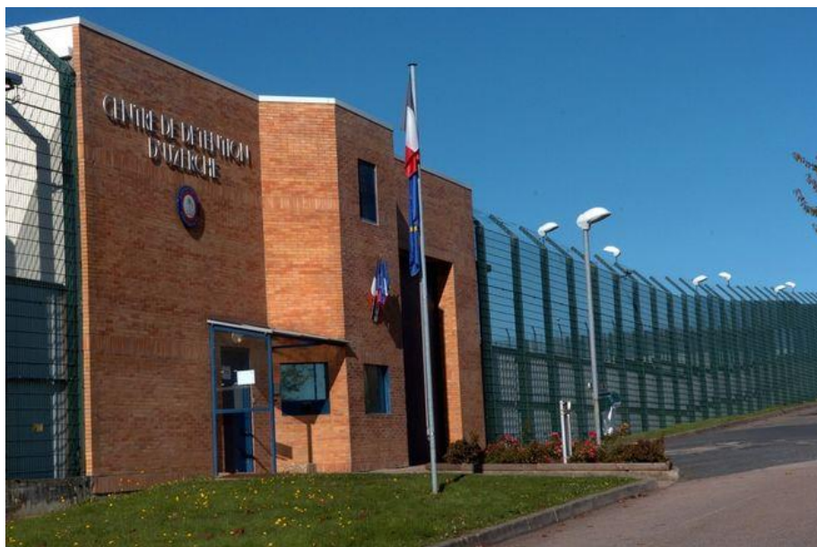
Figure 16 : Photographie de l'entrée du centre de détention d'Uzerche
