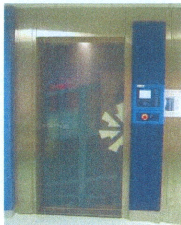
Photographie 3 : Cabine de lavage
