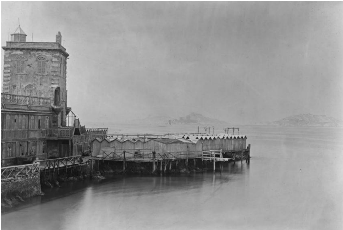
Figure 3 : Tour du Lazaret des Catalans-Marseille
