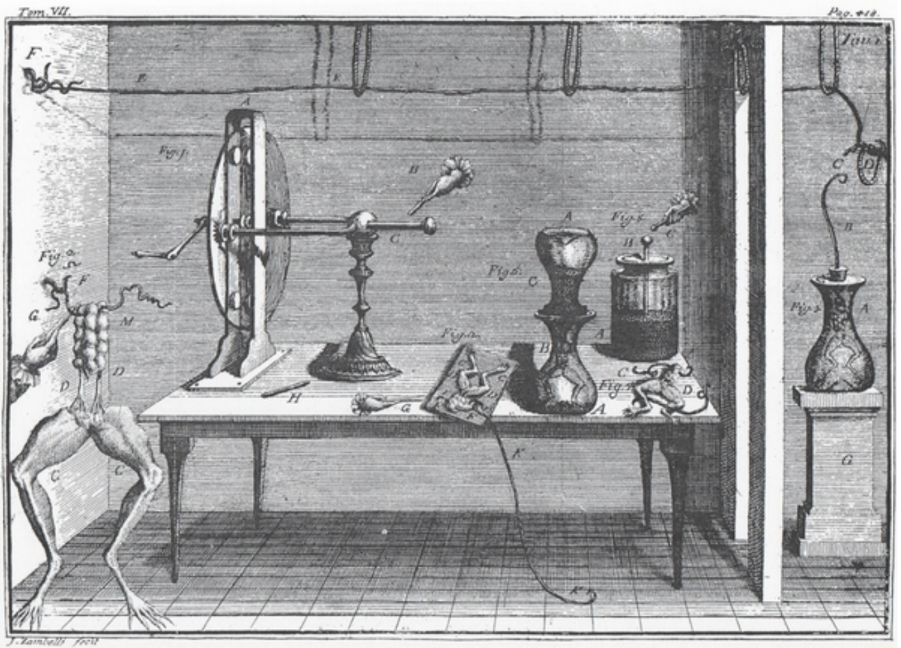
Fig-15. Le laboratoire de Galvani, (Galvani, Commentaire... , 1791). On peut noter sur cette planche à droite les grenouilles préparées c'est-à-dire en ne conservant que leurs membres inférieurs reliés à la moelle épinière par les nerfs cruraux, et tout à fait sur la gauche une bouteille de Leyde.
