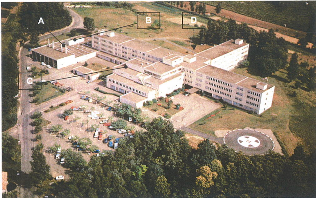
Vue sur la façade Nord
