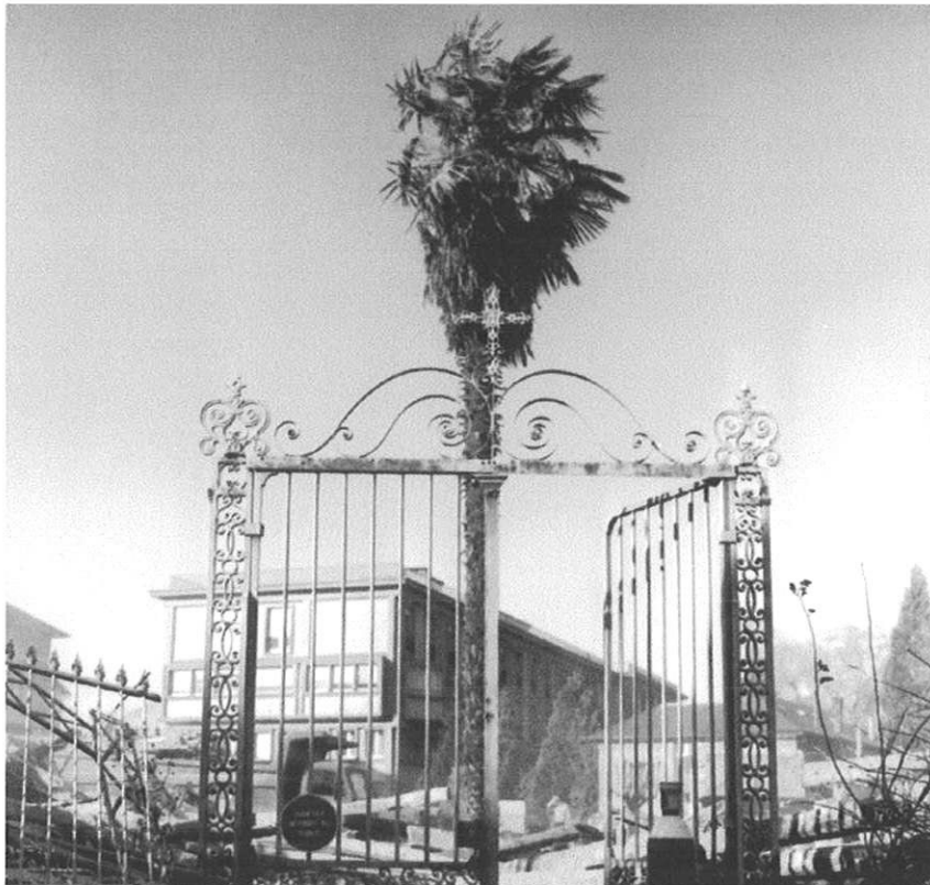
Démolition de l'hôpital-hospice, la grille et le célèbre palmier vivent leurs dernières heures, Hiroshima mon amour !
