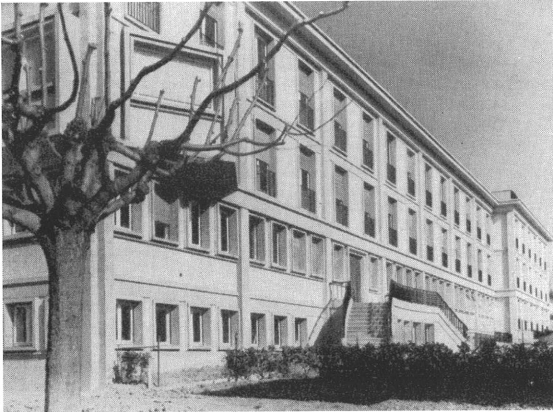
Façade est, ouvrant sur le parc
