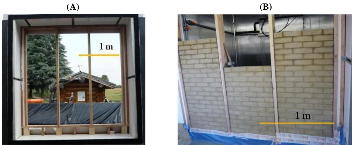
**Figure 14** : (A) ossature bois du mur dans le chariot mobile et (B) mur en phase de construction placé dans la double enceinte.
