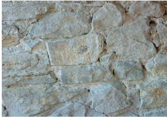
FIGURE 4.30 – Mur en pierre
