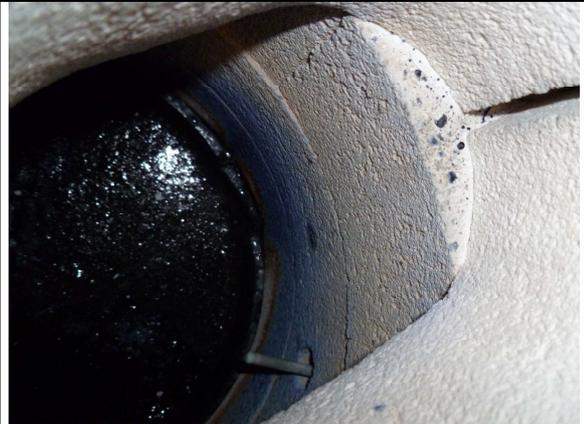
Figure III-13 : Un des thermocouple B placé dans le ciel du réacteur à travers les réfractaires.
