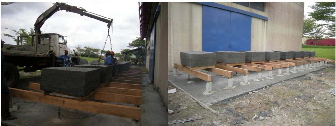
a. Chargement en cours
