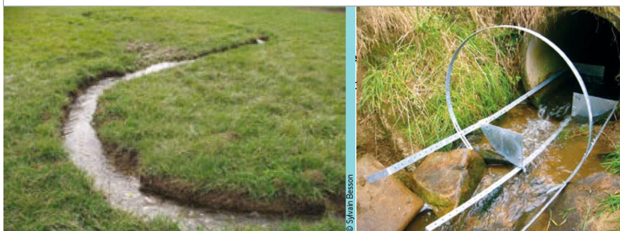
Photographie 59 : Aménagement et contournement d'obstacles à la migration piscicole, Life Ruisseaux de Tête de Bassin, 2008
