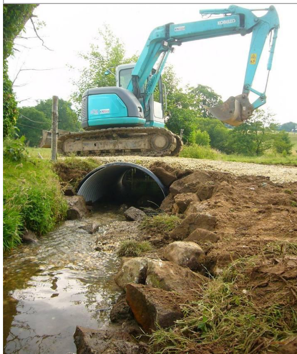
Photographie 47 : Demi-tube PEHD pour bétail et engins Cliché François Bontemps, « Bocage Mayennais »
