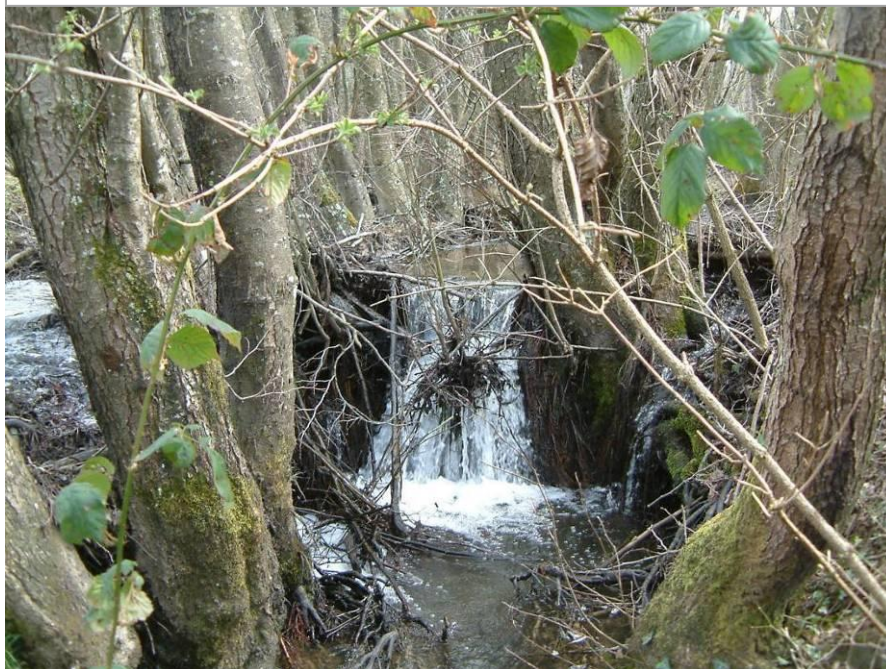
Photographie 14 : Seuils-racines et dégradations engendrées sur le ruisseau de la Prairie : modification de la ligne d'eau, ensablement et rupture de la continuité, Lhéritier N., 2009
