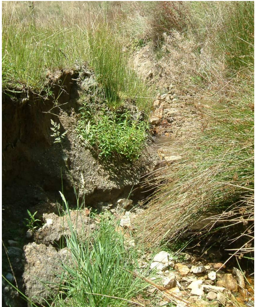
Photographies 34a et b : Érosions de berges limono-sableuse sur le ruisseau de Planchesuge ; clichés : N. Lhéritier, 2009
