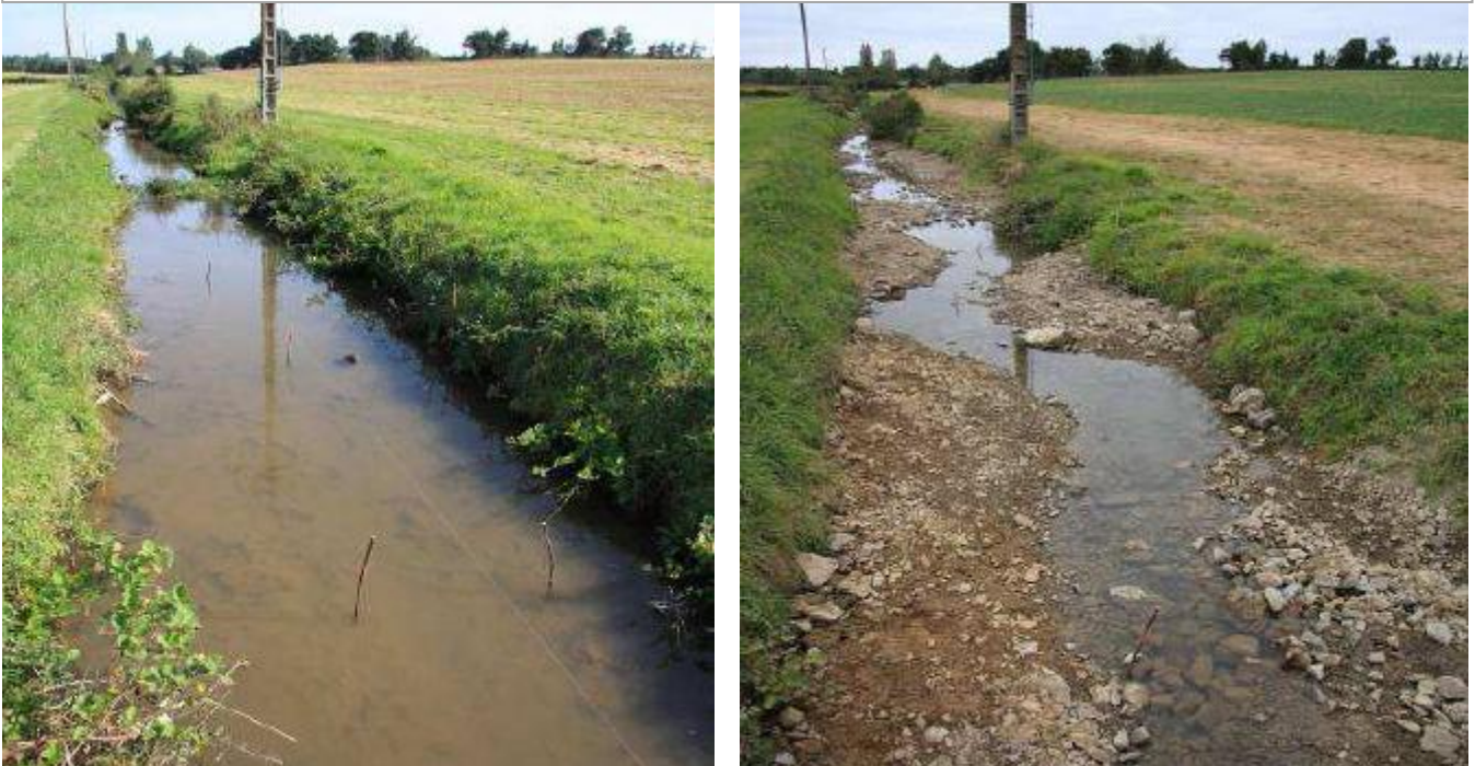
Photographies 58 : Situation avant, et après travaux de recharge en granulats, Bramard M., 2008
