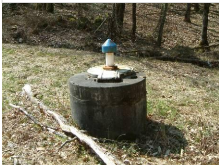
Photographie 10 : Un captage d'eau potable en tête de bassin du ruisseau de la Prairie (87)
