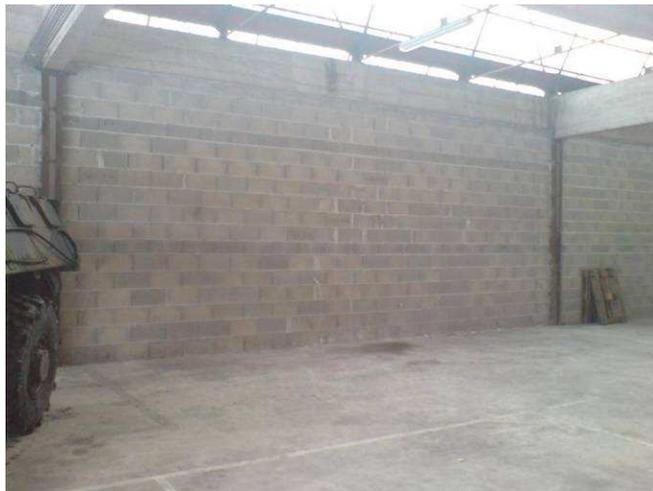
**Figure 14 : Mur en parpaings**
