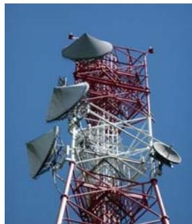
Figure I.2 : Antenne pour faisceaux hertziens.
