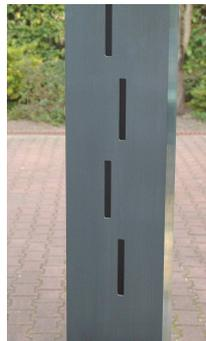
Figure I-9. Antenne à fentes rayonnantes
