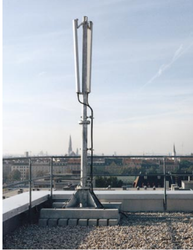
FIG.1.22 – Antenne sectorielle de 65° pour la bande des 1800 MHz
