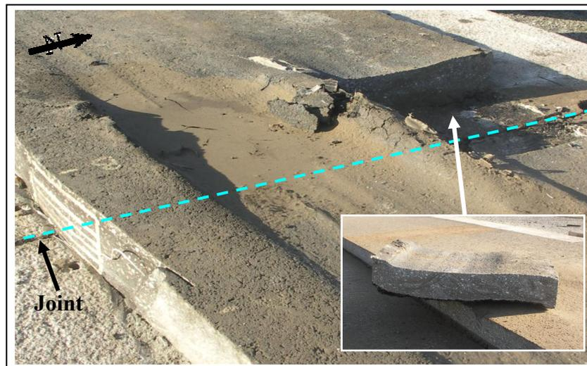
Figure 2.40 – Orniérage et fluage latéral de la couche de sable bitume – joint N° 2
