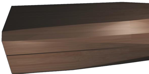
FIG. 4.24 – Exemple d'apparition de fente sur une poutre
