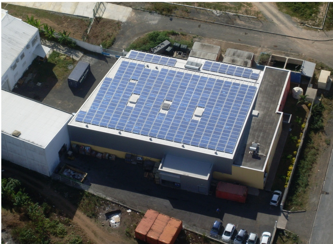
Photographie 50 : Installation photovoltaïque sur le toit d'une entreprise à Mayotte
