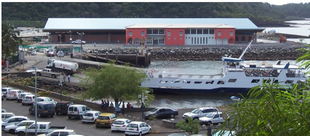
Photographie 51 : 3 000 m 2 de toitures : marché couvert de Mamoudzou – façade principale
