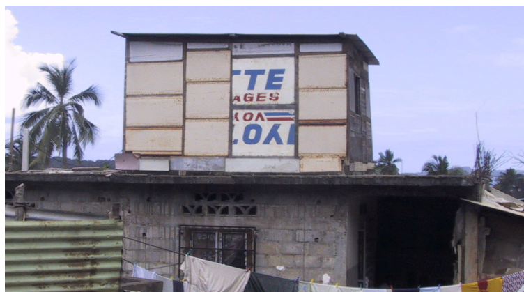
Photographie 29 : Cases en tôle sur une dalle en béton dans le quartier de Lazérévouni (Kawéni).
