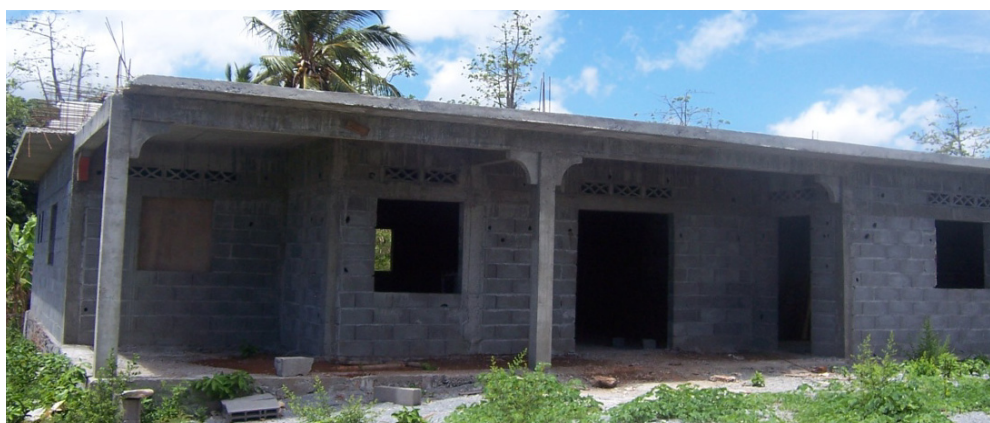
Photographie 28 : Construction d'une maison en dur
