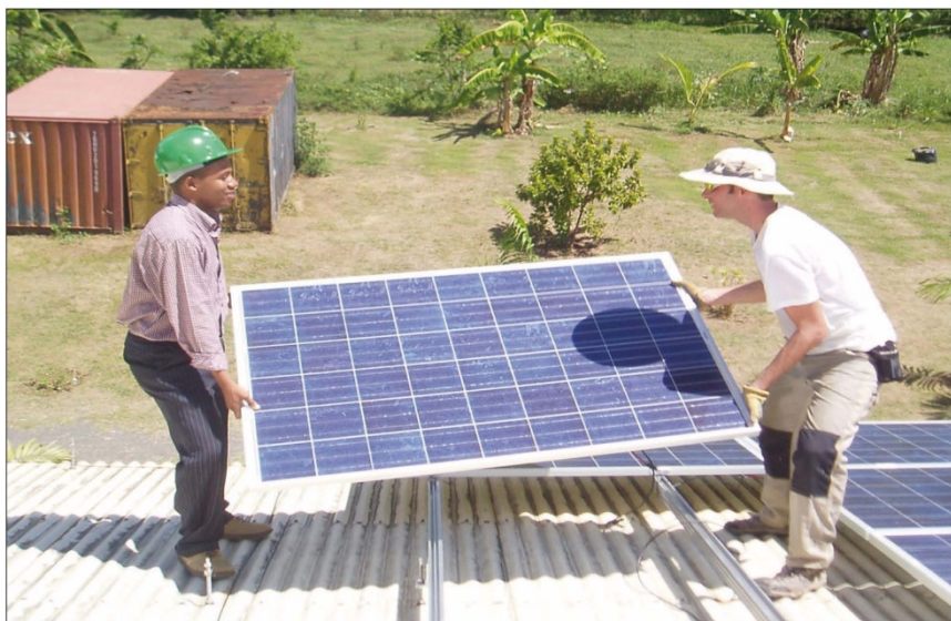
Mise en place des panneaux solaires sur les toits de la DEDD.
