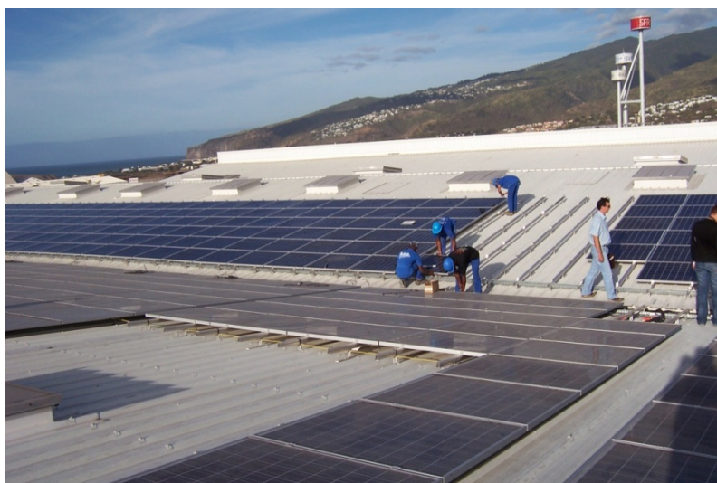
Photographie 48 : Installation d'une centrale de 1MWc à la Réunion
