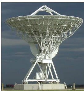
figure I.7. Réflecteur parabolique : système focalisant en réflexion
