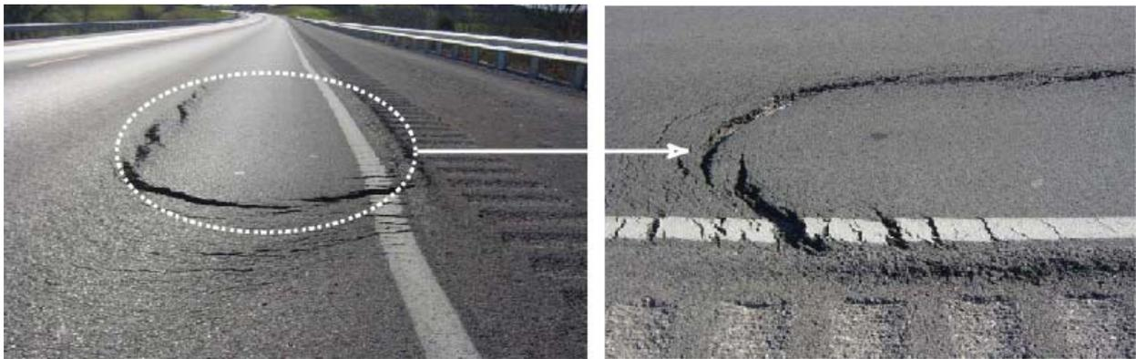
**Figure I.4-2.** Exemple de dégradation due à un défaut de collage à l'interface [BUC 04]
