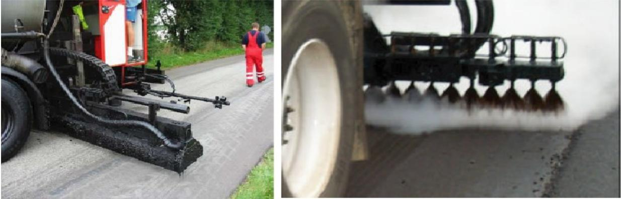
**Figure I.4-5.** Réalisation d'une couche d'accrochage avec un répandeur [RAS 02]
