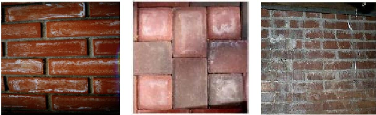
**Figure 3-1: Les murs affectés par efflorescence fine.**
