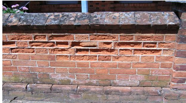
Figure 4-15 : Un exemple réel d'altération très forte sur un mur.
