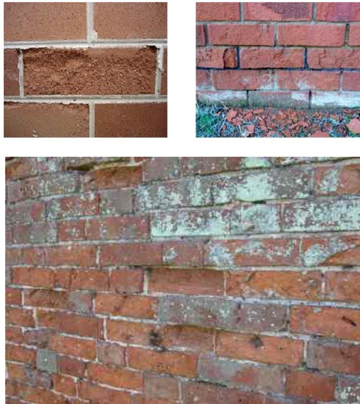
Figure 4-11 : Trois images réelles des dommages structuraux. Dans la rangée supérieure, nous pouvons voir l'érosion et l'effritement (à gauche), et l'élimination de la couche extérieure (à droite). Dans l'image du bas tous les problèmes d'efflorescence, d'effritement et l'élimination de la couche extérieure sont réunis.
