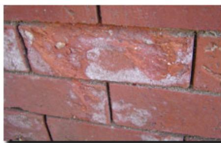
Figure 3-8 : Effet de sous-efflorescence (crypto-efflorescence) sur le mur de briques.
