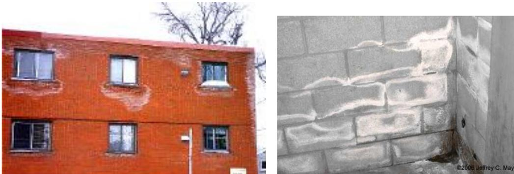
Figure 1-3 : Des constructions affectées par efflorescence
