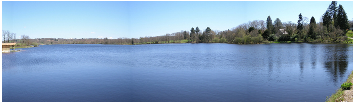
Photo I-11 : Le Grand Etang de Cieux vu depuis l'extrémité nord de la digue (cliché Carlini 2004)
