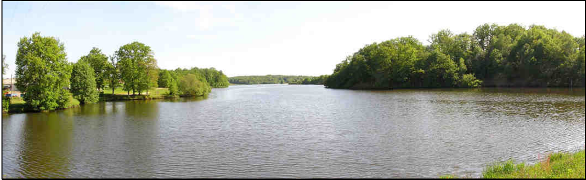
Photo 5 : L'étang de la Pouge depuis la digue (cliché Carlini 2005)
