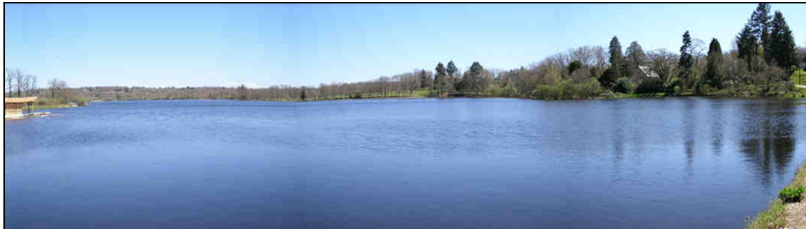
Photo 4 : Le grand étang de Cieux depuis le nord de la digue (cliché Carlini 2004)
