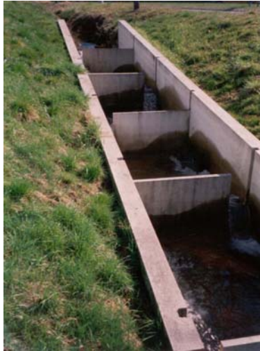
Photographie 65 : Echelle à poisson de l'étang de Gorre (87).
