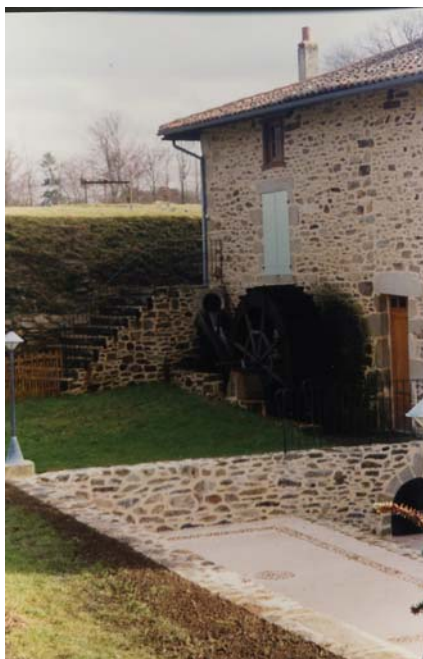
Photographie 14 : Roue verticale du moulin de Tranchepie aménagé en résidence secondaire (Veyrac, 87).
