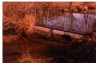
grille de protection contre les fuites de poissons (étang du Masgontier) (commune de Saint-Priest-Ligoure)
