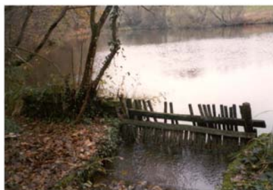
grille ancienne en bois (commune de Rilhac-Lastours) grille plus récente en métal (commune de Saint-Hilaire-les-Places)
