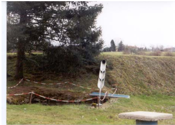
Photographie 44 : Déversoir par tuyau aérien caractéristique des petits étangs (Nieul, 87).
