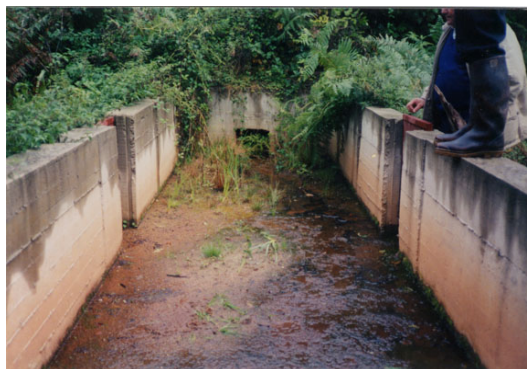
Photographie 48: Nouvelle pêcherie en béton de l'étang de Masmangeas (Sardent, 23).
