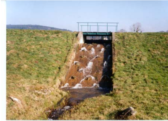
Photographie 43 : Déversoir moderne à La Jonchère-Saint-Maurice (87).
