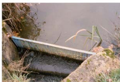
Figure 28 : Les différentes générations de grilles de déversoir d'étang.
