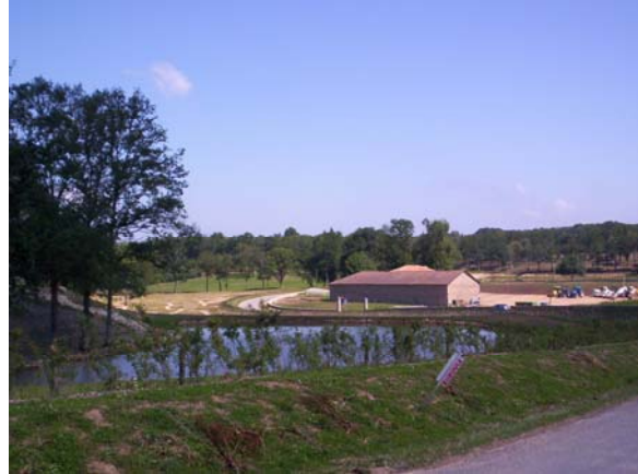
Photographie 52 : Les abords de l'étang de Ballerand en travaux au cours de l'été 2005 (Marval, 87).
