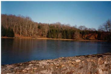
Vue d'une partie de l'étang de Feuyas à partir de sa digue
