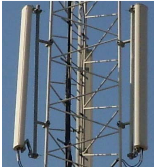
Figure II.8. Exemple d'antenne sectorielle (3 secteurs)
