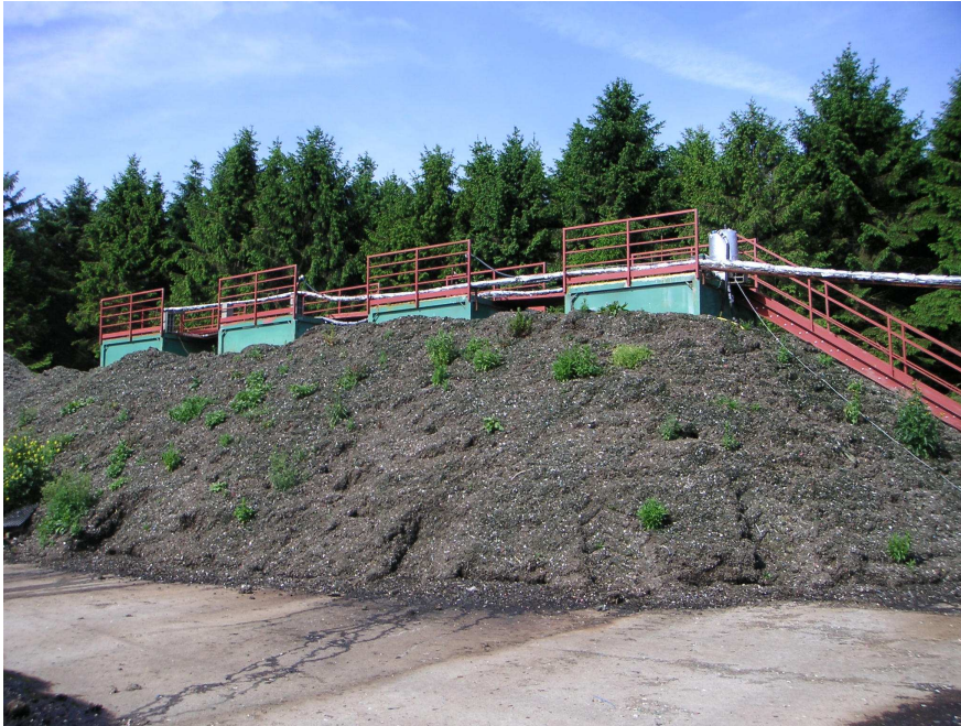
Photo 1 : Vue des différents casiers après leur mise en place
