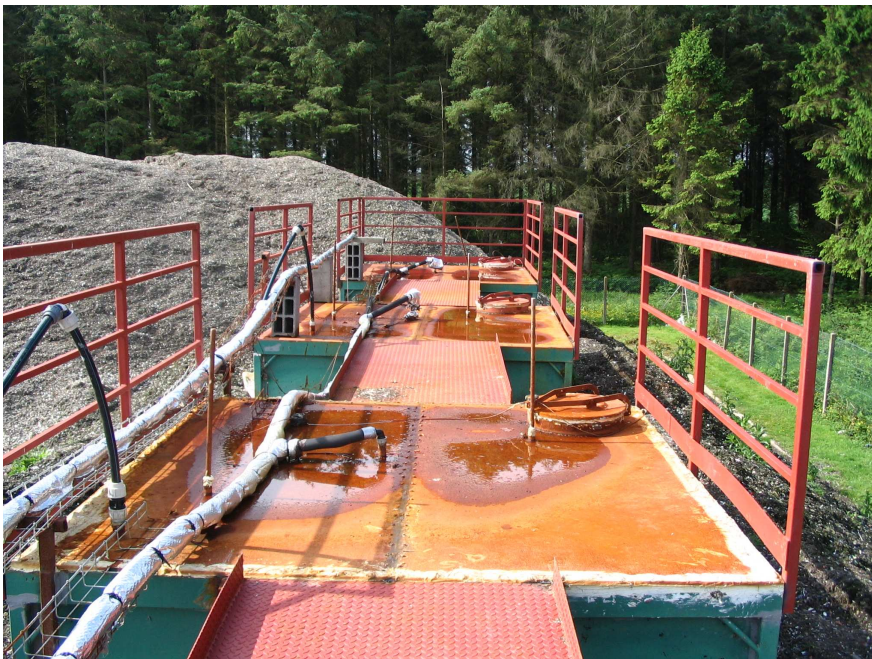
Photo 2 : Dispositif de captage du biogaz et de simulation des pluies (casiers vue d'en haut)
