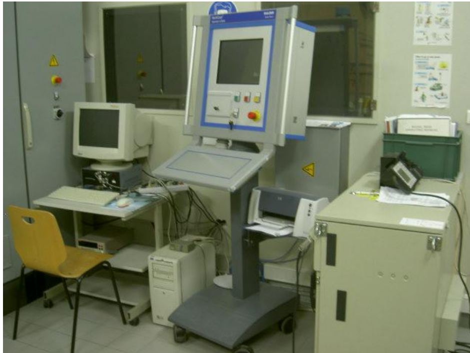
Figure 17 : Aperçu extérieur de l'installation de projection plasma du SPCTS
