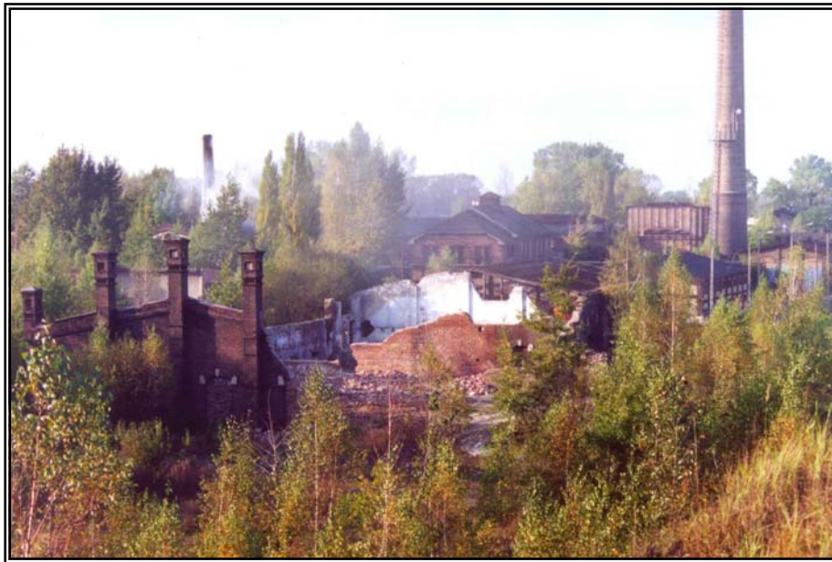
Figure I.6. Etat actuel de bâtiments d'ancienne fonderie de zinc à Świętochłowice-Lipiny (photo prise en 2001).
