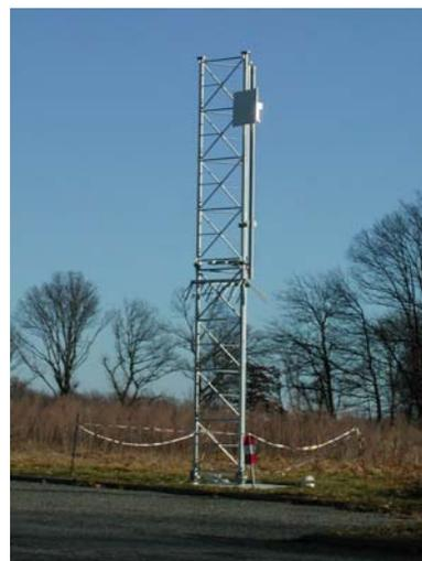
*Figure IV.21 : Le réflecteur et les récepteurs qu'il dessert.*
