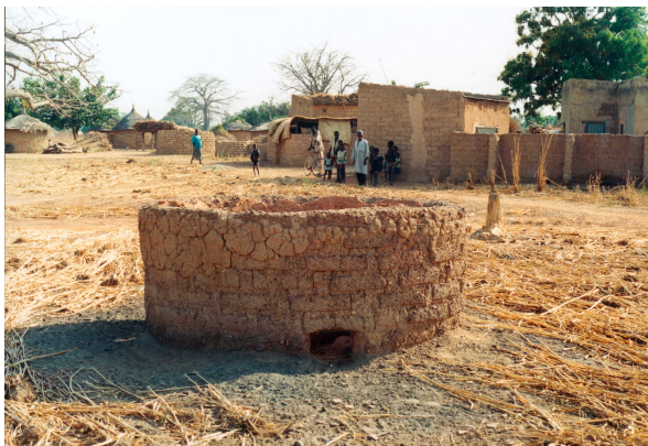
Figure i: Vue générale d'un village avec son four traditionnel.
