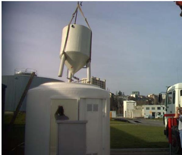
Figure II-5 : Mise en place du pilote dans l'igloo à la station d'épuration de Limoges
